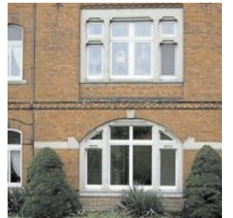
Arbeiten an Fenstern gehören in die Hand eines Fachmanns. Foto: Reckendrees
